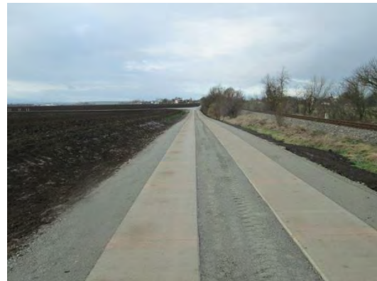
Betonspurweg bei Guthmanshausen. Quelle: ALF Gotha.
