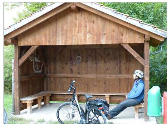
Schutzhütte in Kleinbreitenbach Quelle: LRA IK.
