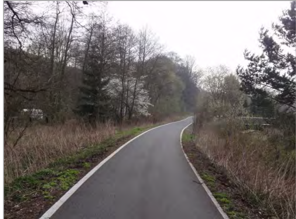
Randstreifenmarkierung am Ilm-Rennsteig-Radweg. Quelle: C. Gerbig.
