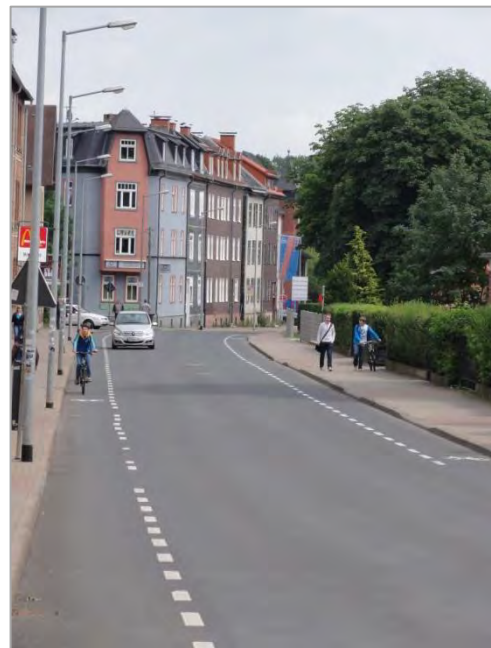
Schutzstreifen in Ilmenau, Langwiesener Straße. Quelle: C. Gerbig.
