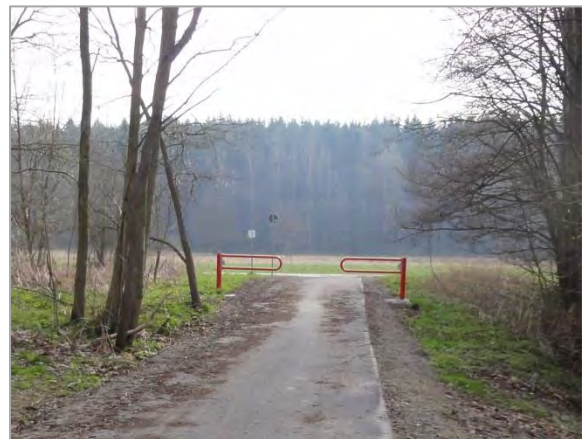
Beispiel gut erkennbarer Durchfahrtssperren am Ilmtal-Radweg zwischen Ilmenau und Gräfinau-Angstedt. Quelle: C. Gerbig.
