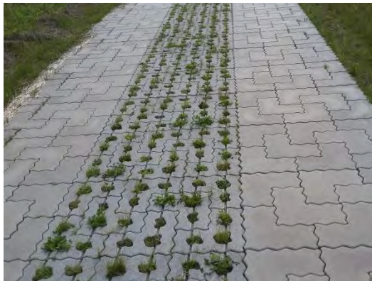
Gut befahrbar: Großformatiges Betonpflaster mit teilversiegeltem Mittelstreifen am Saaleradweg bei Calbe. Quelle: LRA IK.
